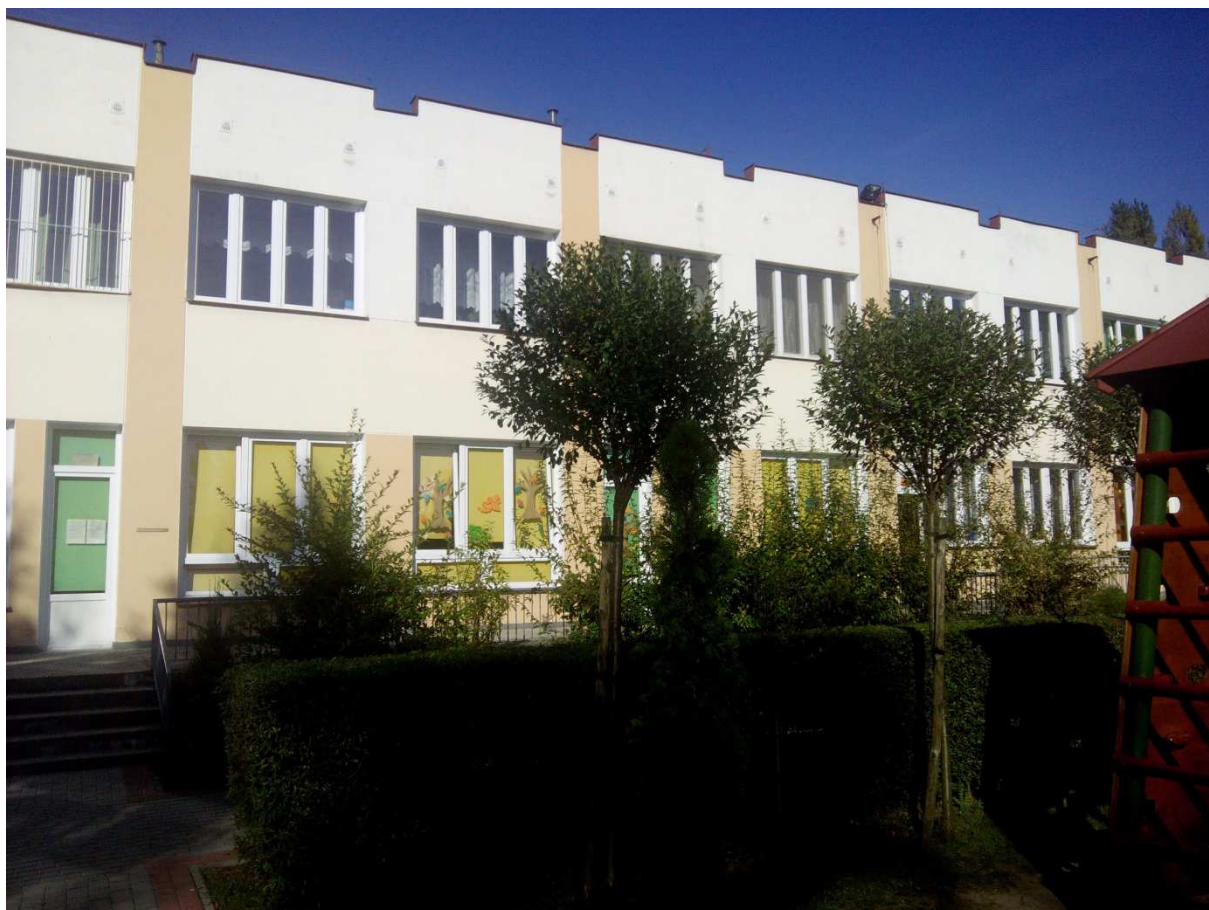
Widok elewacja [ S ]
